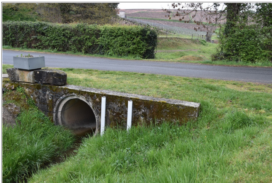
Figure III 10: buse de franchissement du chemin des Peupliers.
