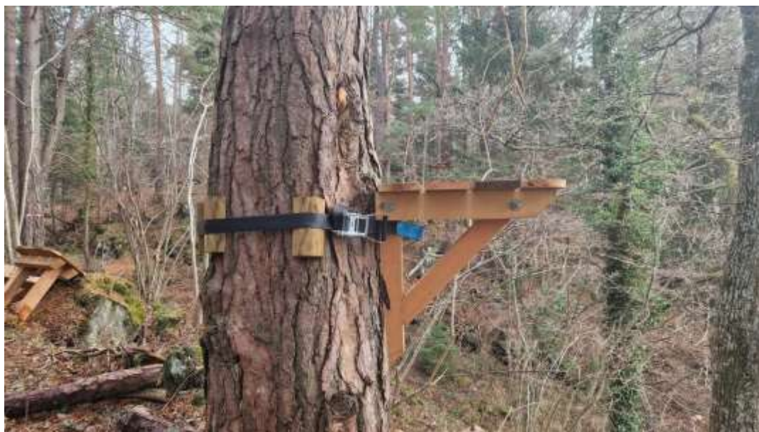
Figure 9 : Plateforme type, accrochée à l'arbre par une sangle et des protections en bois pour ne pas blesser le support
