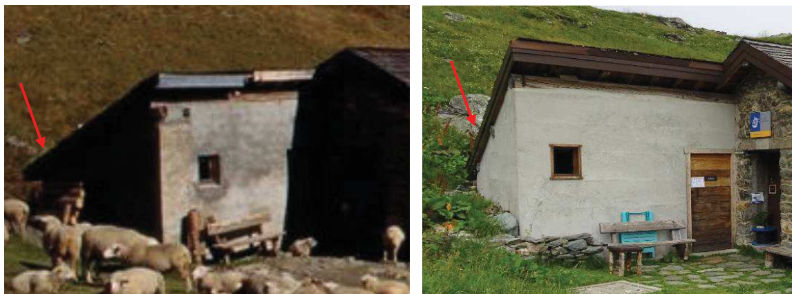
Fig. 10 : évolution de l'annexe « bûcher – WC » du refuge avant et après travaux de rénovation en 2008 ou 2010. Noter le débord de toit raccourci, pour éviter le soulèvement de toiture constaté en 2006.
