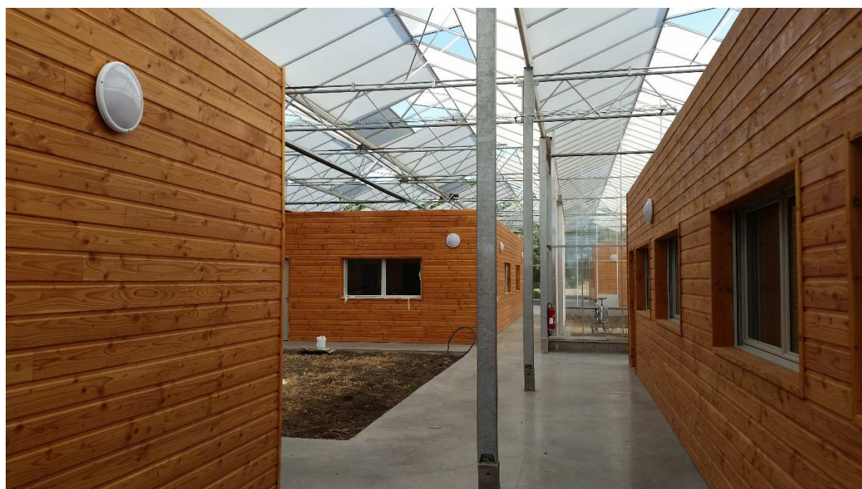
Figure 18 : Exemple de bureaux en ossature bois sous multi-chapelles - point de vue intérieur (source : Domaine de Chapelan, Juillet 2020)
