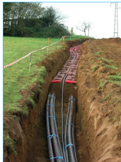
Tranchée avec fourreaux PEHD
