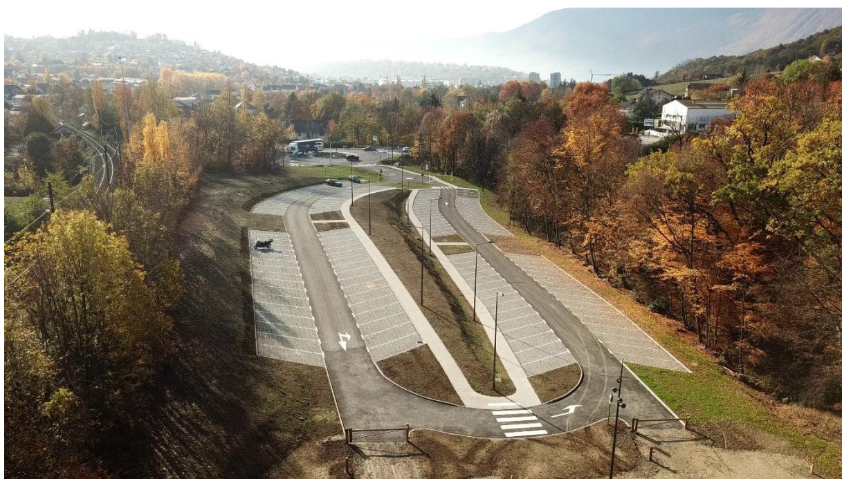
Figure 10 : Illustration d'une réalisation de parking de covoiturage avec dalles alvéolées gravillonnées
