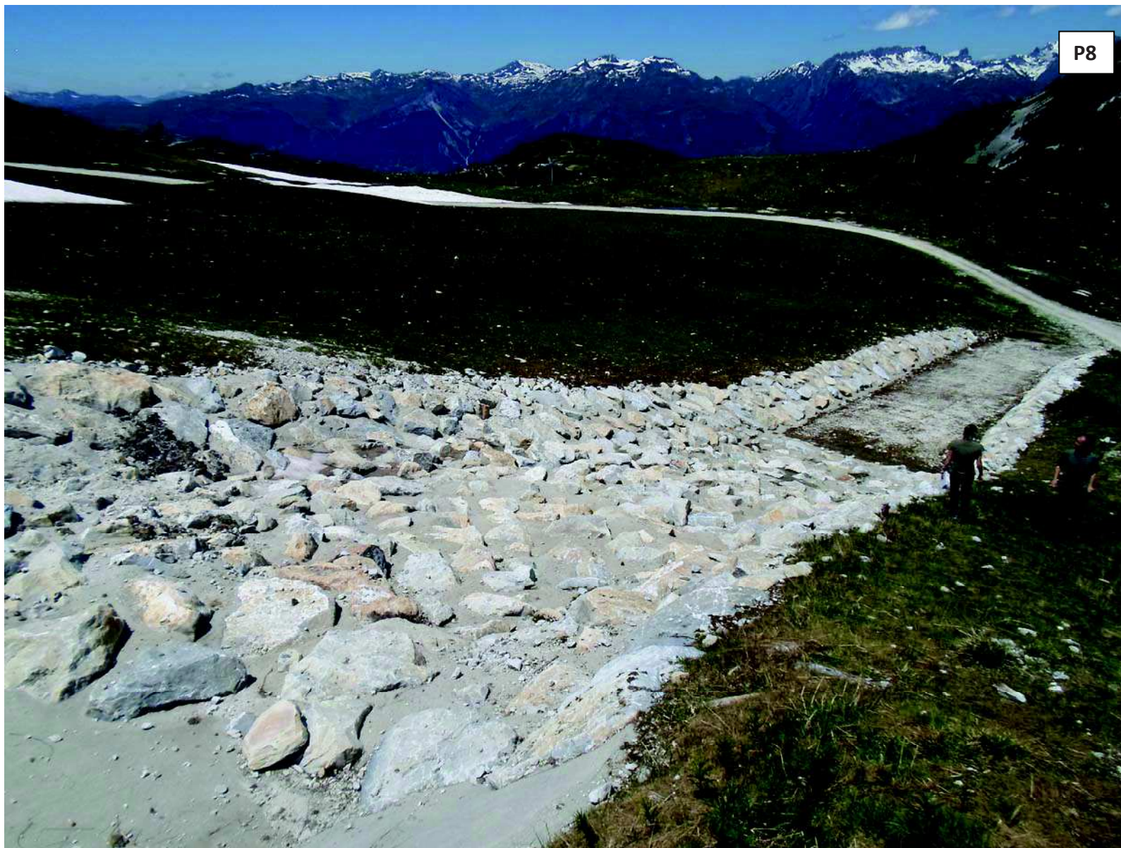
Photographie 8 : vue du déversoir de crue et de la future zone de remblai (28-06-2016)
