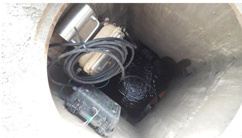
Débitmètre de type SIGMA 950 "bulle à bulle" avec sonde doppler hauteur-vitesse - Point R19
