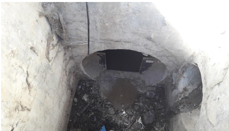
Seuil avec sonde piézométrique (câble noir)- Point R37
