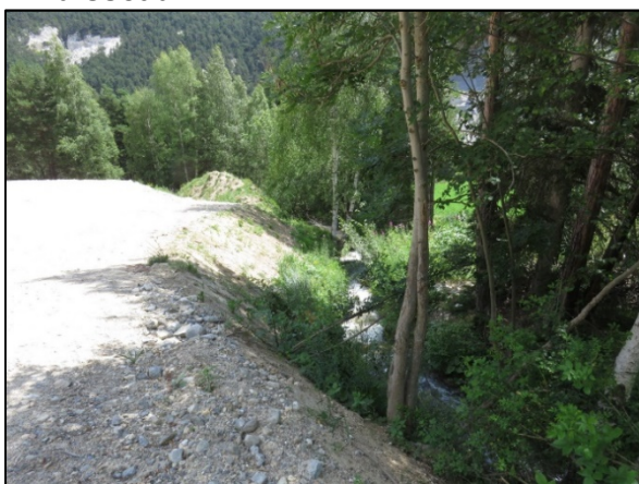
Photo 8 : Le remblaiement de la voie d'accès en limite rive gauche du ruisseau
