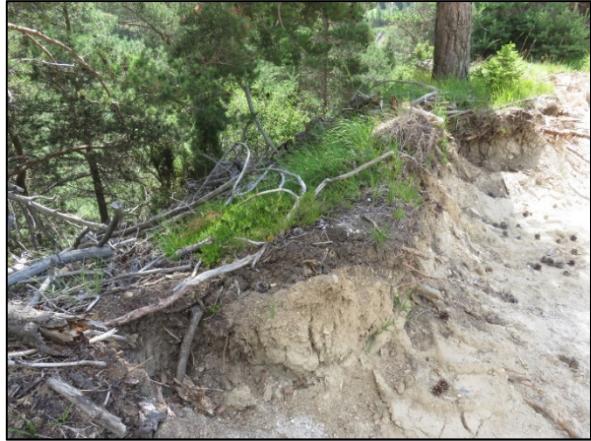
Photo 6 : Talus graveleux, avec des traces de ruissellement
