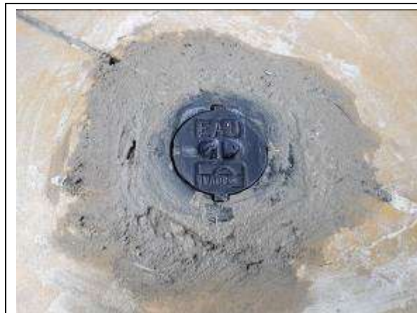
Mise en place de la bouche à clé
