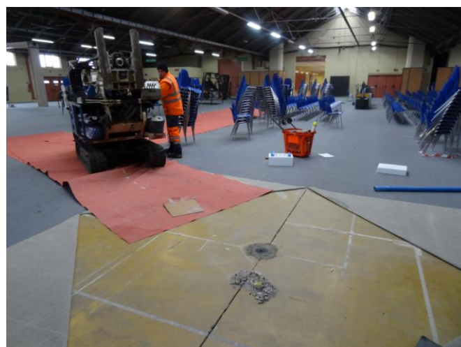
Déplacement de la foreuse après la mise en place d'un Piézair
