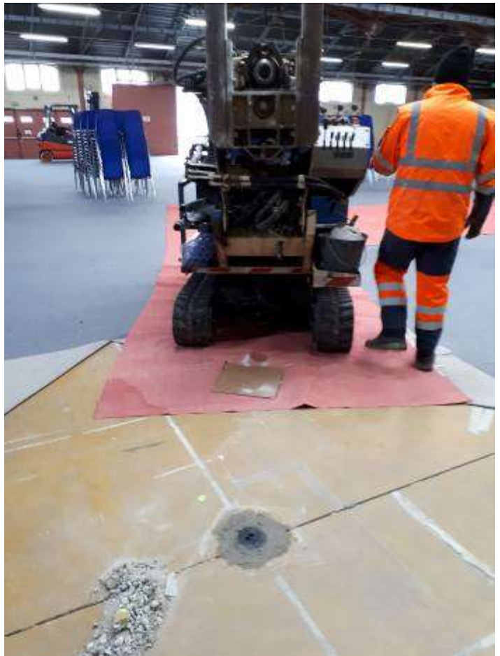
Découpe et protection de la moquette Pose de piézaiers
