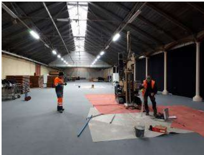
Forage et sécurisation à l'avancement
