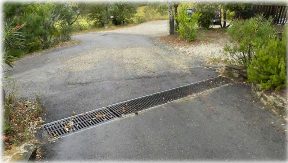
Caniveau grille pour collecter les eaux pluviales sur les voiries du camping actuel (Cliché IATE, 05/09/2024)
