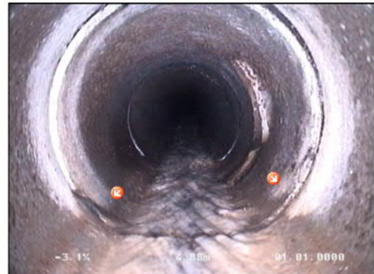
Photo: 28_28_63_A.JPG 5,1m, Infiltration de 04 à 08 h.
