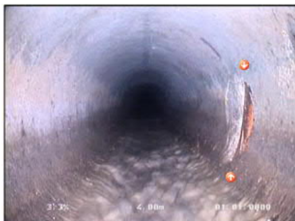
Photo: 9_9_24_A.JPG 4,3m, Armatures visibles à 03 h.
