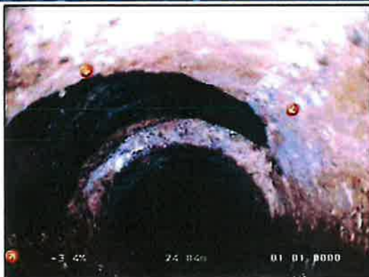
Photo: 35_35_102_A.JPG 25m, Réparation ponctuelle, étanchéité incertaine
