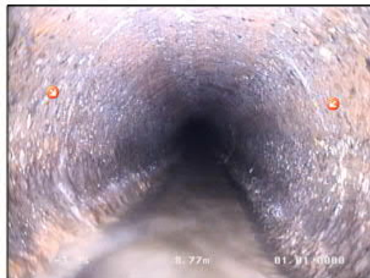
Photo: 1_1_163_A.JPG 9m, Fissure circulaire
