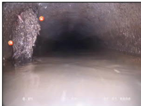
Photo: 7_7_19_B.JPG 25,3m, Perforation à 10 h avec pénétration de racines.
