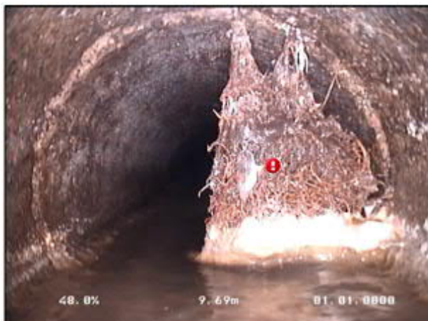
Photo: 16_16_89_A.JPG 9,9m, Racines et radicelles avec obstruction partielle de 12 à 06 h.
