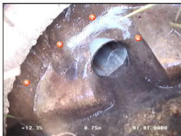
Photo: 10_10_30_A.JPG 0,1m, Infiltrations importantes dans le regard R41.
