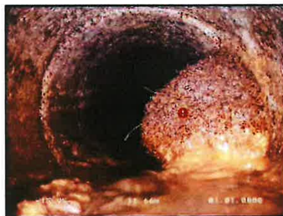
Photo: 16_16_90_A.JPG 11,9m, Racines et radicelles avec obstruction partielle de 03 à 06 h.
