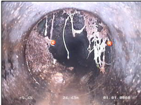
Photo: 44_44_169_A.JPG 24,7m, Racines et radicelles avec obstruction partielle de 07 à 04 h.
