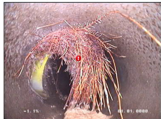
Photo: 32_32_74_A.JPG 31,8m, Racines et radicules avec obstruction partielle de 09 à 01 h au niveau du branchement.
