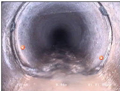
Photo: 28_28_62_A.JPG 1,2m, Infiltration de 04 à 08 h.
