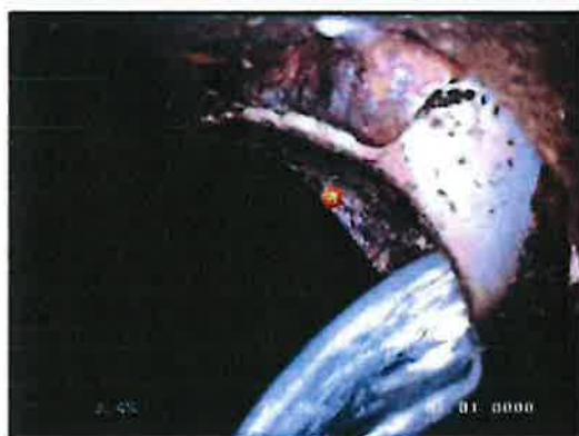
Photo: 50_50_148_A.JPG 26,5m, Raccordement pénétrant à 02 h.
