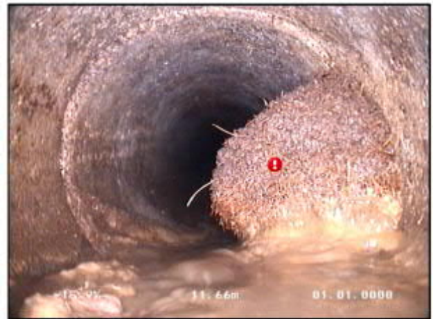
Photo: 16_16_90_A.JPG 11,9m, Racines et radicelles avec obstruction partielle de 03 à 06 h.
