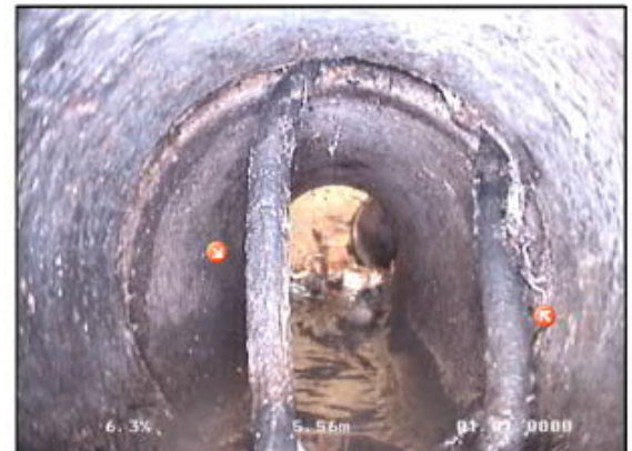
Photo: 46_46_173_A.JPG 5,9m, Joint défectueux de 10 à 05 h.
