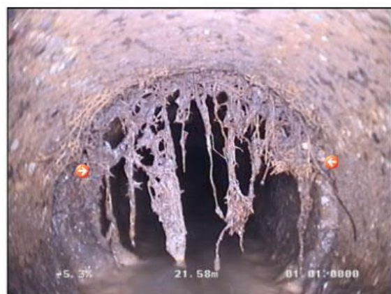
Photo: 39_39_119_A.JPG 21,9m, Racines et radicules avec obstruction partielle de 07 à 05 h.
