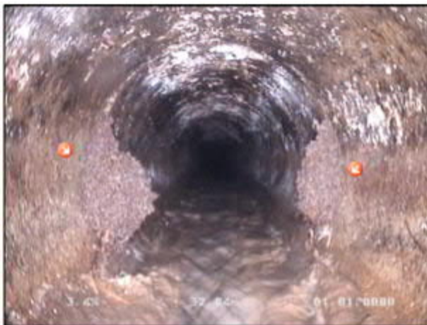
Photo: 15_15_86_A.JPG 33,2m, Racines et radicelles avec obstruction partielle de 03 à 09 h.
