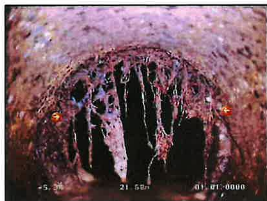
Photo: 39_39_119_A.JPG 21,9m, Racines et radicelles avec obstruction partielle de 07 à 05 h.
