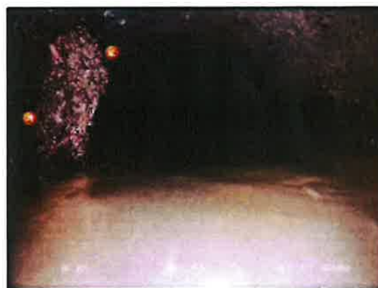
Photo: 7_7_19_B.JPG 25,3m, Perforation à 10 h avec pénétration de racines.
