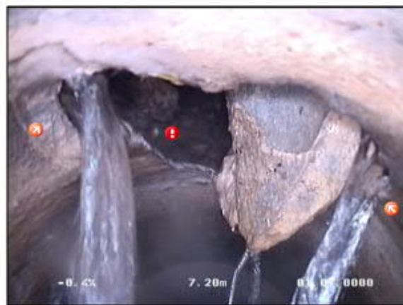
Photo: 10_10_31_B.JPG 7,2m, Infiltrations importantes via une perforation de 10 à 02 h.
