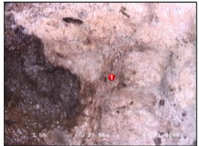
Photo: 25_25_128_B.JPG 23,9m, Concrétions de 02 à 06 h (infiltrations, jonction regard/canalisation)
