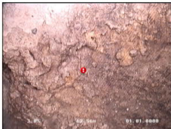
Photo: 12_12_34_B.JPG 62,6m, Concrétions de 08 à 04 h (jonction regard/canalisation, infiltrations)
