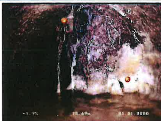
Photo: 6_6_14_A.JPG 19m, Racines et radicelles avec obstruction partielle de 12 à 05 h.
