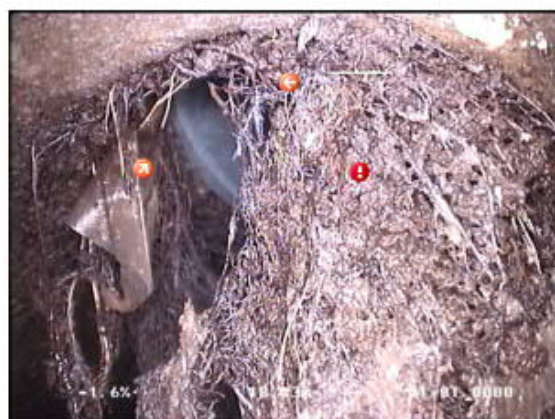
Photo: 6_6_14_B.JPG 19m, Racines et radicelles avec obstruction partielle de 12 à 05 h.
