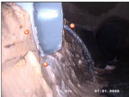
Photo: 29_29_60_A.JPG 79,3m, Infiltration à 09 h dans R271.
