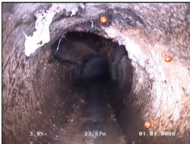
Photo: 25_25_128_A.JPG 23,9m, Concrétions de 02 à 06 h (infiltrations, jonction regard/canalisation)
