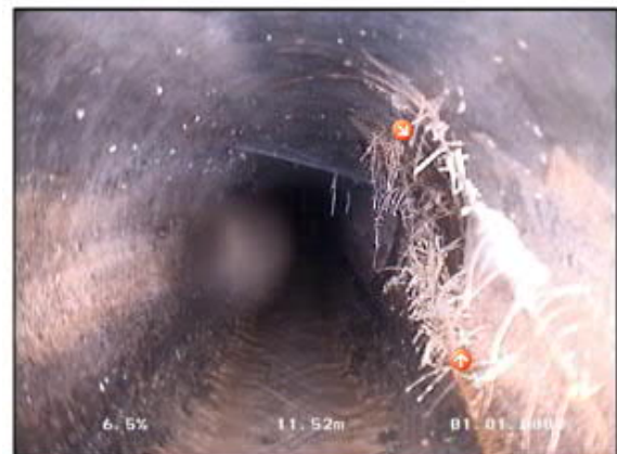
Photo: 45_45_178_A.JPG 11,8m, Perforation de 01 à 05 h avec pénétration de racines.
