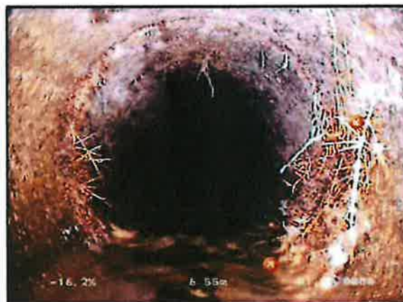
Photo: 16_16_88_A.JPG 6,9m, Racines et radicelles avec obstruction partielle de 01 à 11 h.
