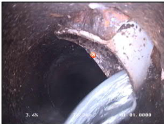
Photo: 50_50_146_A.JPG 26,5m, Raccordement pénétrant à 02 h.
