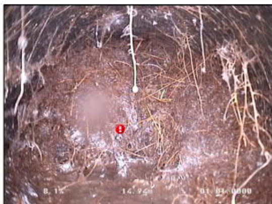
Photo: 45_45_179_A.JPG 15m, Racines et radicelles avec obstruction totale de 12 à 12 h.
