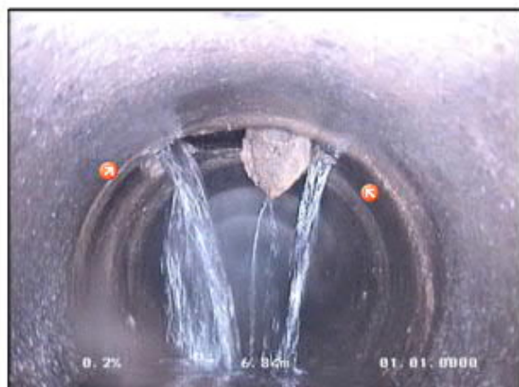
Photo: 10_10_31_A.JPG 7,2m, Infiltrations importantes via une perforation de 10 à 02 h.
