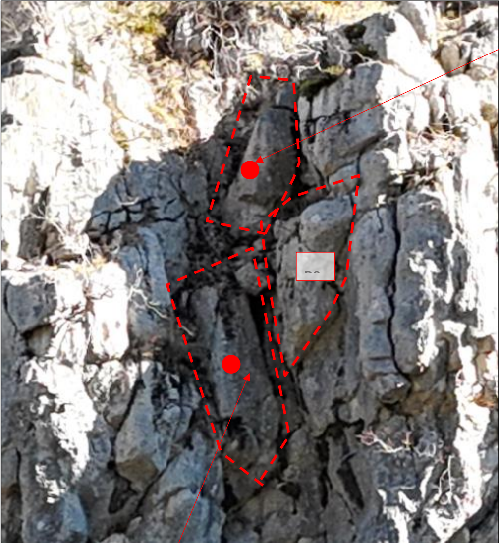
B1 : 2.2 x 0.8 x 1 m Bloc bien découpé en pied mais assis en pied (Aléa Moyen) A conforter par 1 ancrage GEWI 25 lg 2.8 m (2 m en arrière du plan de fracturation) foré en Ø57 mm.
