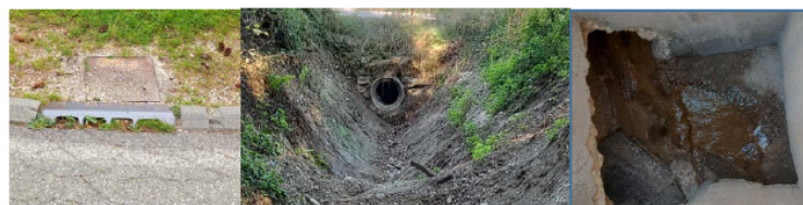
Avaloir obstrué (VC n°1) – Busage du thalweg du Turc en Ø600 B – Réduction du collecteur EP Ø600 B en Ø400 B
