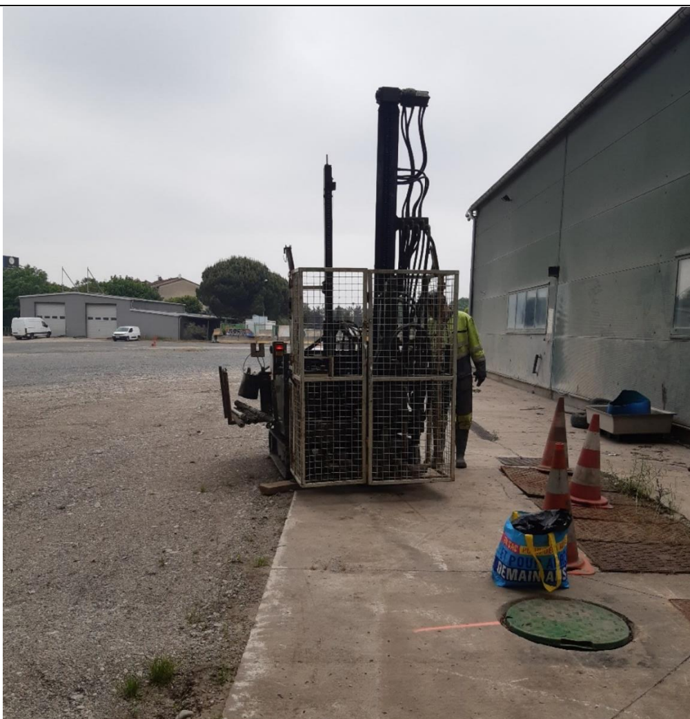
Vue de l'implantation du Sondage 3 à proximité immédiate du séparateur hydrocarbure de l'ancienne station de lavage du hangar.
