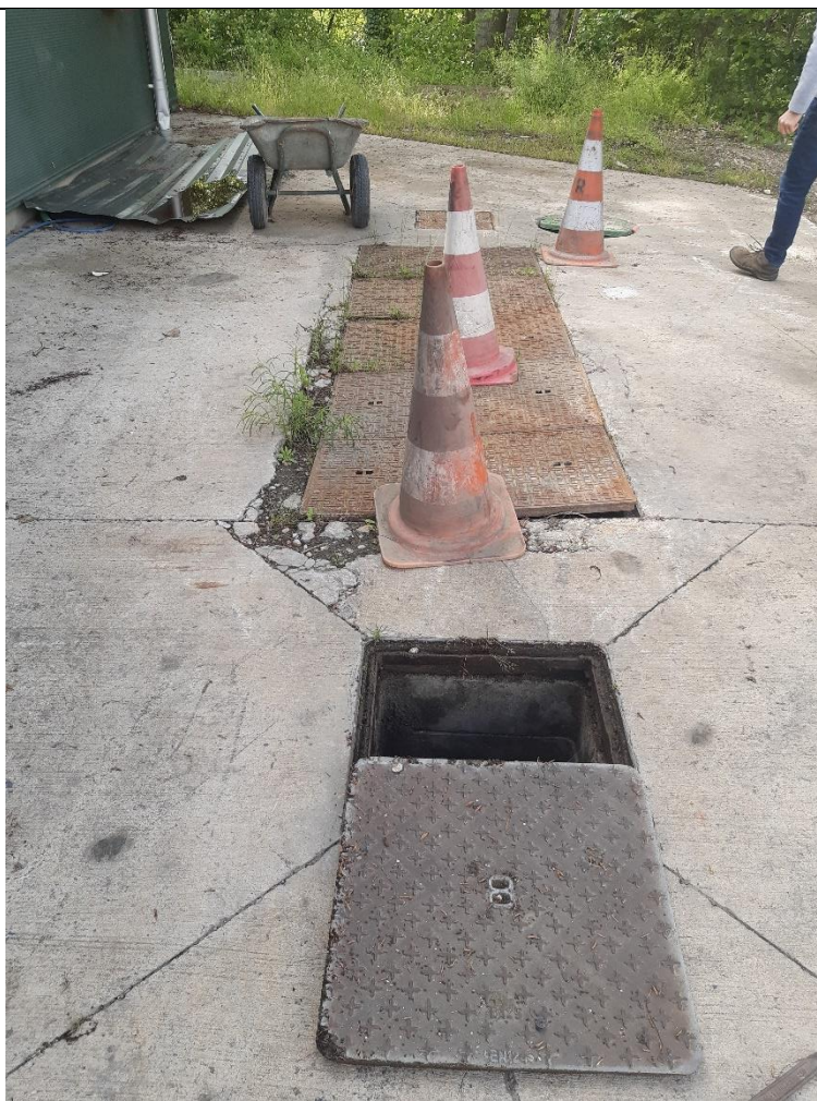
Vue du séparateur hydrocarbure au droit de la station de lavage du transporteur
