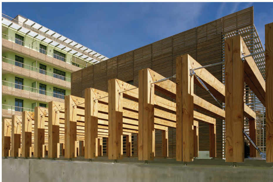
La Duchère. 51 logements / MO : Grand Lyon Habitat / Maître d'oeuvre : Gautier+Conquet Rampe d'accès au parking en limite de parcelle, couverte par une ombrière bois.
