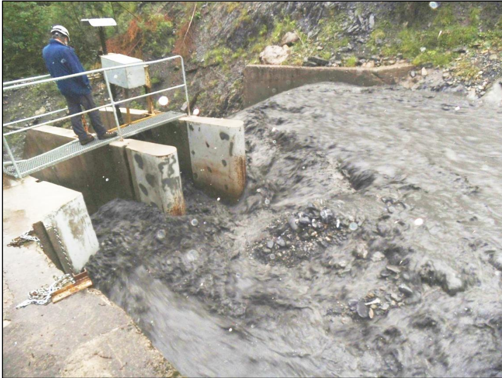
Figure 45: photo d'un épisode de lave torrentielle à la prise d'eau EDF du Pradin
