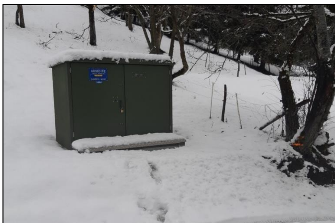
Figure 21: Poste de transformation de tension et de coupure existant au droit du bâtiment usine projeté
