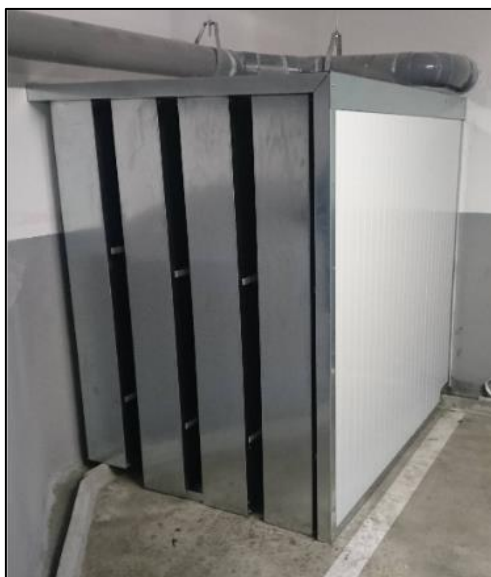
Figure 59: exemple de caisson acoustique faisant office de piège à sons ((c) Cometac)
