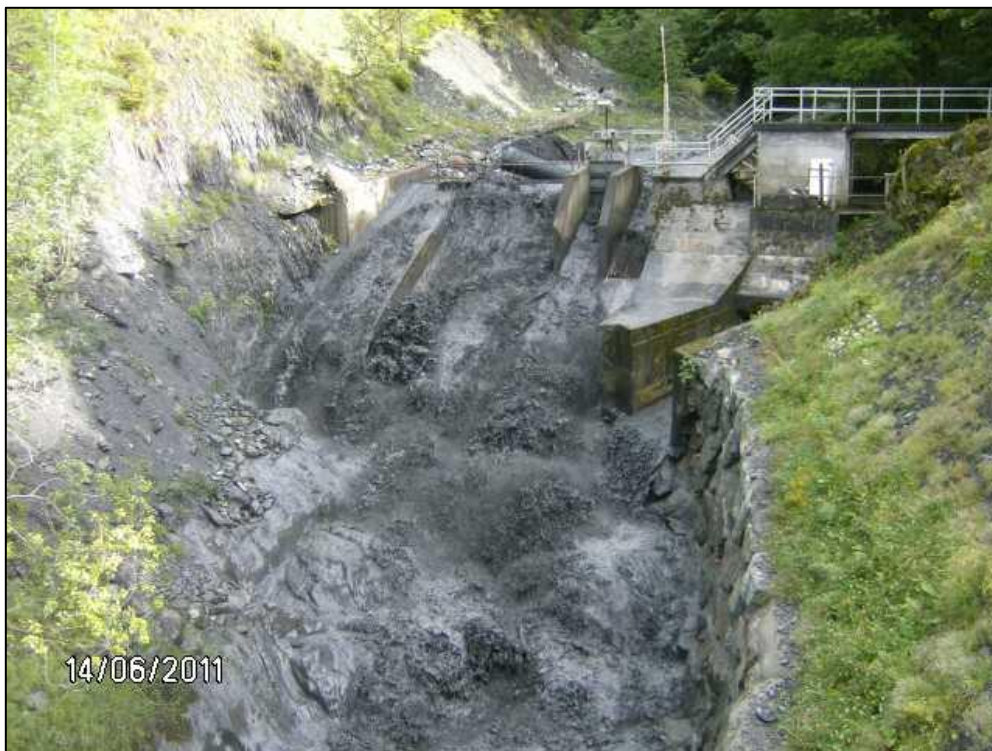
Figure 46: photo d'un épisode de lave torrentielle à la prise d'eau EDF du Pradin vue de l'aval
