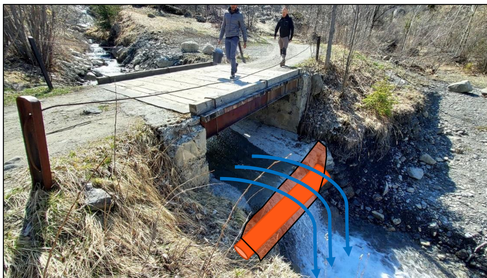
Figure 27: Coffrage pour la traversée du ruisseau de la Praz
