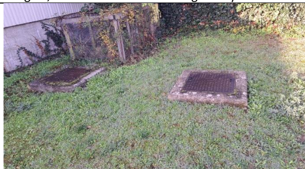
Trous d'hommes de la cuve à 2 compartiments. Le dépotage n'a pas été retrouvé (tuyaux se dirigeant vers le hangar). Elle alimentait un volucompteur, qui était situé de l'autre côté du chemin (parcelle 0192). Les événements sont situés dans la haie proche.
