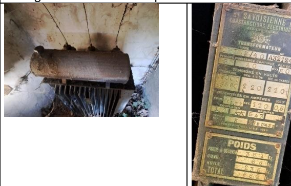
Intérieur du transformateur et sa cuve de fluide diélectrique au PCB.
