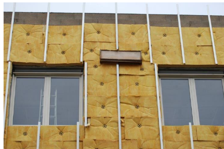
Photographie 45 : Gîte artificiel entouré de la première couche d'isolant à l'IUT de Bourges (Arthur & Chrétien, 2020)
