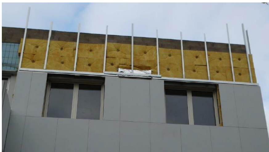
Photographie 46 : Gîte artificiel entouré d'isolant avec un bardage incomplet à l'IUT de Bourges (Arthur & Chrétien, 2020)
