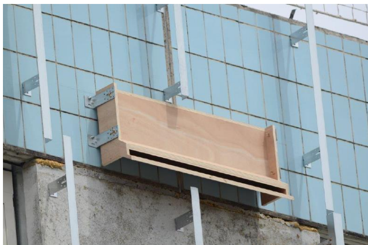
Photographie 44 : Installation du gîte artificiel au niveau des corniches à l'IUT de Bourges (Arthur & Chrétien, 2020)
