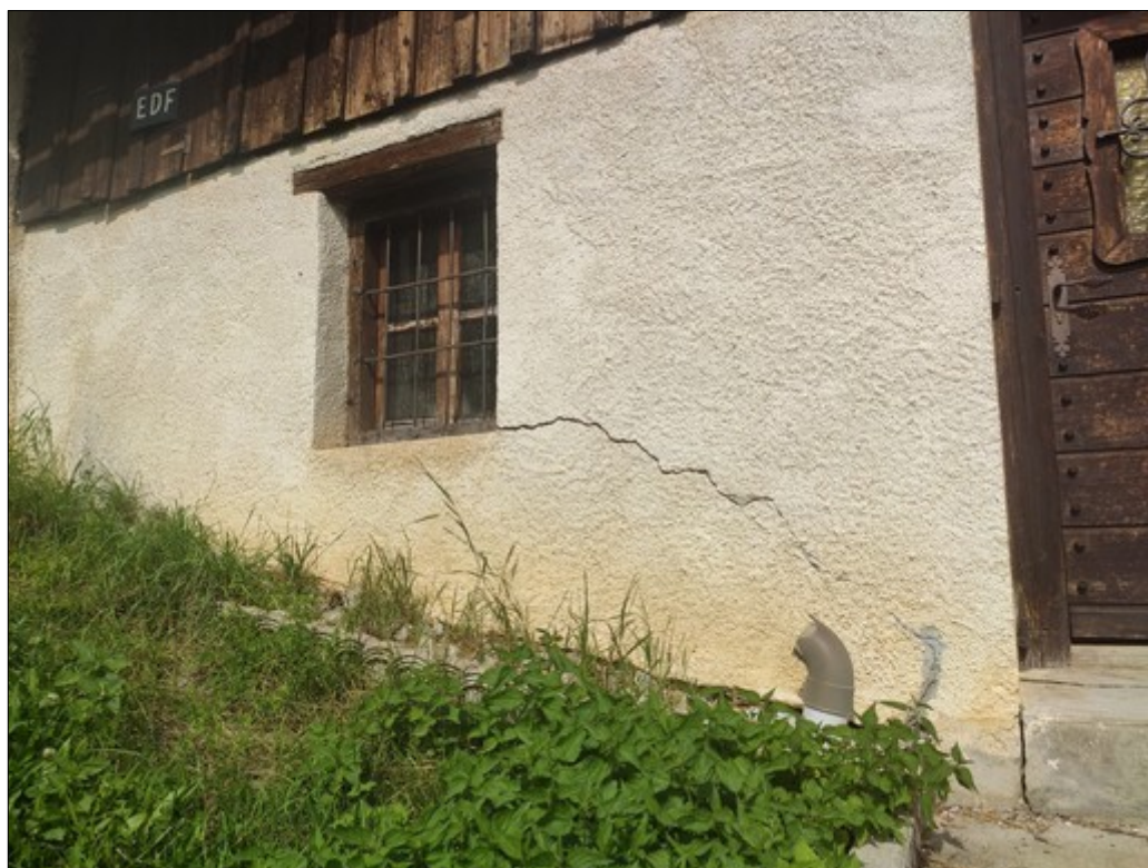
Figure III.5: Fissuration du mur Ouest du chalet en parcelle 1113
