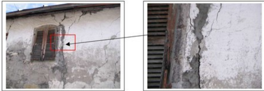
Fissures sur les murs d'une maison au hameau de Chaucisse – Les Témoins mis en place en avril 1983 attestent que le glissement est toujours actif. Source : MB Management, novembre 2009
