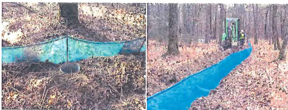
Mise en œuvre de la barrière-piège pour les amphibiens (source : BIOTOPE®)
