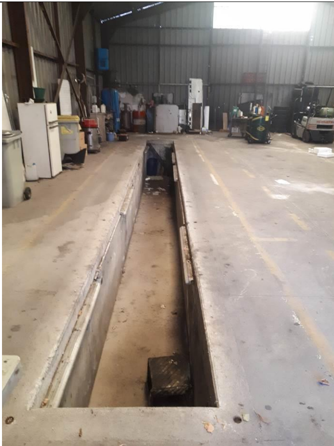
Photographie 7 : Fosse maçonnée Source : Prise de vue DEKRA
