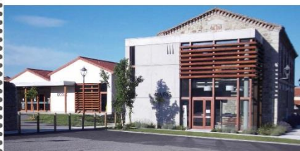
Exemple de lames orientées fixes
