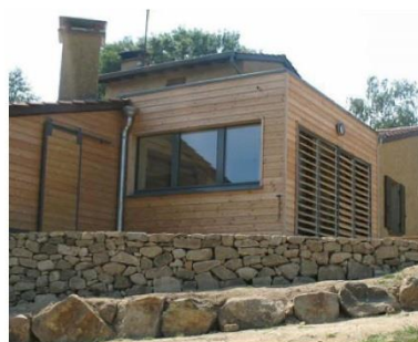
Exemple de lames orientables mobiles
