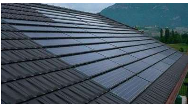
Non respect des ouvertures et des lignes de la toiture ce qui crée un « trou »
