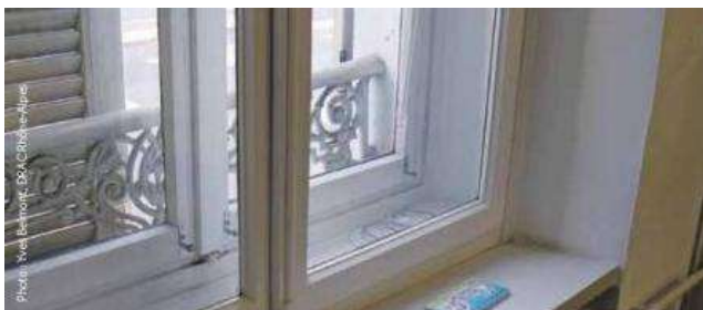
▲ Figure 9 Exemple de double fenêtre mise en œuvre côté intérieur avec isolation thermique intérieure complémentaire. Réalisation à Lyon.
