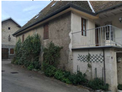
Pied de mur perméable et végétalisé
