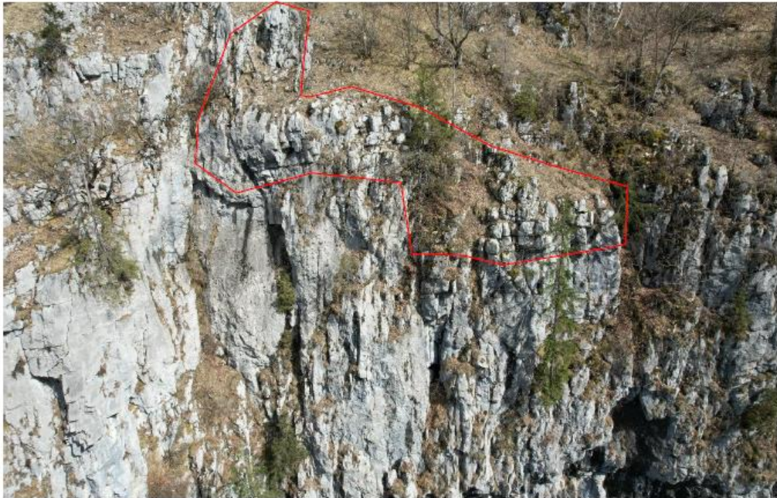
Photo 25 Zone déstructurée et altérée en tête de paroi (phénomène de type pierres et blocs)
