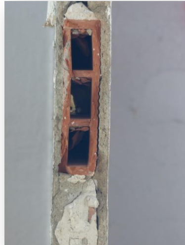
Briques dans les cloisons
