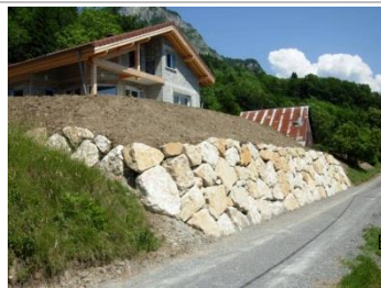
Exemple d'enrochements interdits
