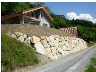
Exemple d'enrochements interdits
