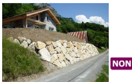
Exemple d' enrochements interdits
