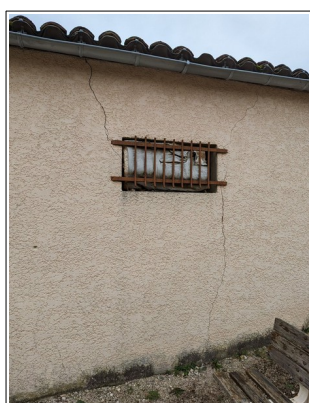
Photo 33: Bâtiment fissuré à proximité de la rupture de pente dans le bourg, proche de la cure et de l'église).
