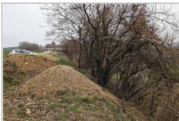
Photo 36: Apport de remblais qui surcharge la tête de talus près de Fichailon, alors que des glissements se sont déjà produits ici.
