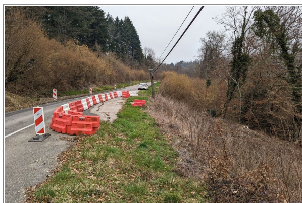
Photo 34: Affaissement de la chaussée lié au ruissellement et à l'affouillement des berges par le ruisseau de Bouvant.
