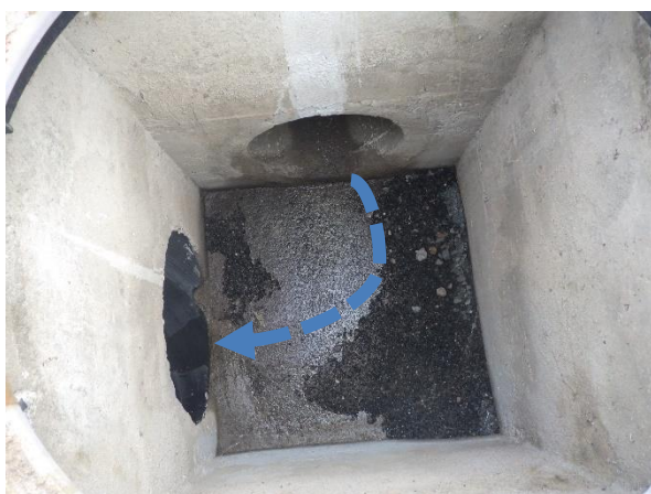
Augmentation du \varnothing de la canalisation - Route des Morguiers
