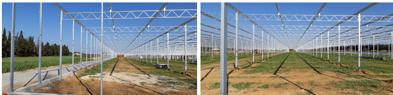
Figure 18 - Montage structure d'une serre photovoltaïque. Source : Reden Solar.
