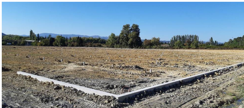
Figure 20 - Fondations béton extérieures (longrine). Source : Reden Solar.
