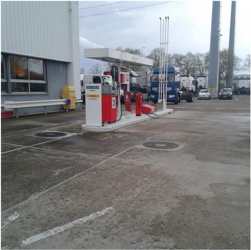
Photo 7 : Station-service pour les véhicules de société, regards des cuves et dépotage carburant
