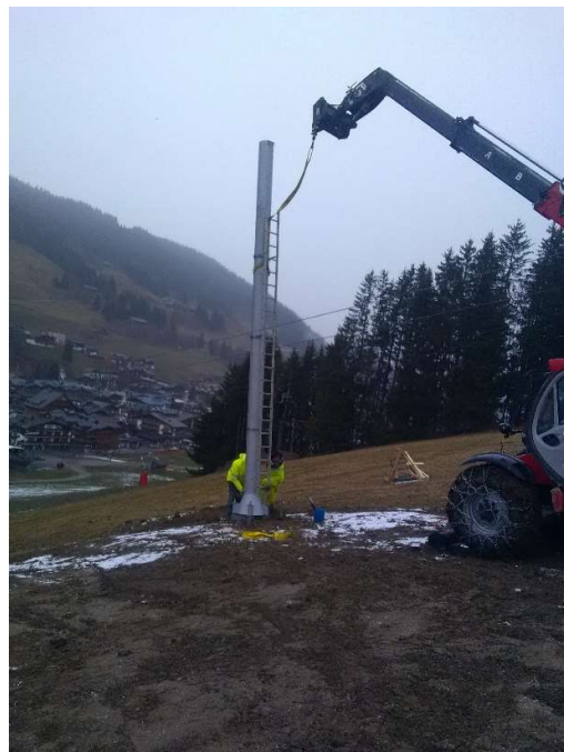
Pose du pylône après remblaiement
