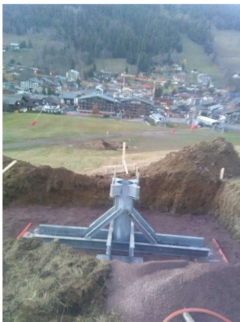
Mise en place des fondations de type embase métallique
