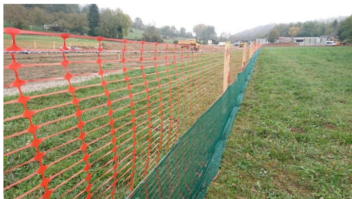
Figure 24. Exemple d'une barrière plus efficace car bien tendue (Ecotope 2019)
