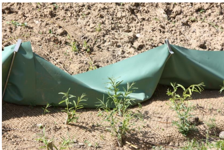
Figure 23. Exemple d'une barrière à amphibiens inefficace en phase chantier. Les linéaires de barrières sont à suivre régulièrement. (Ecotope 2009)
