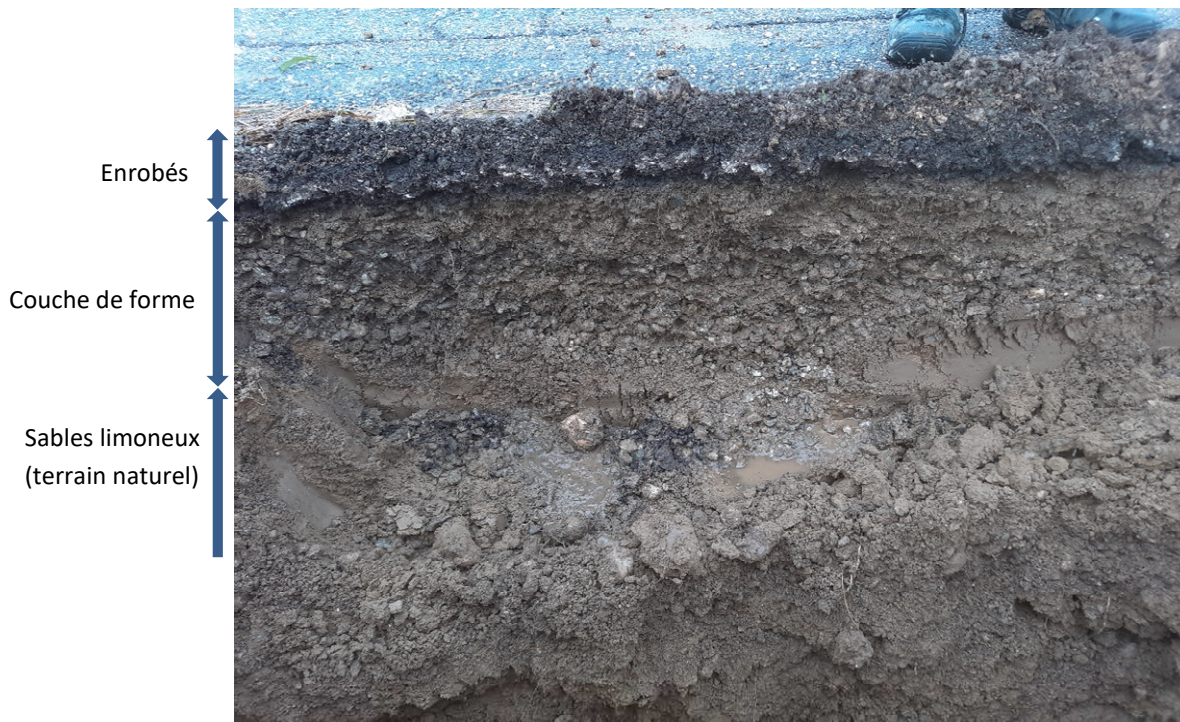
Photo 1 – Structure de voirie de l'Impasse du Longet, ECR Environnement
