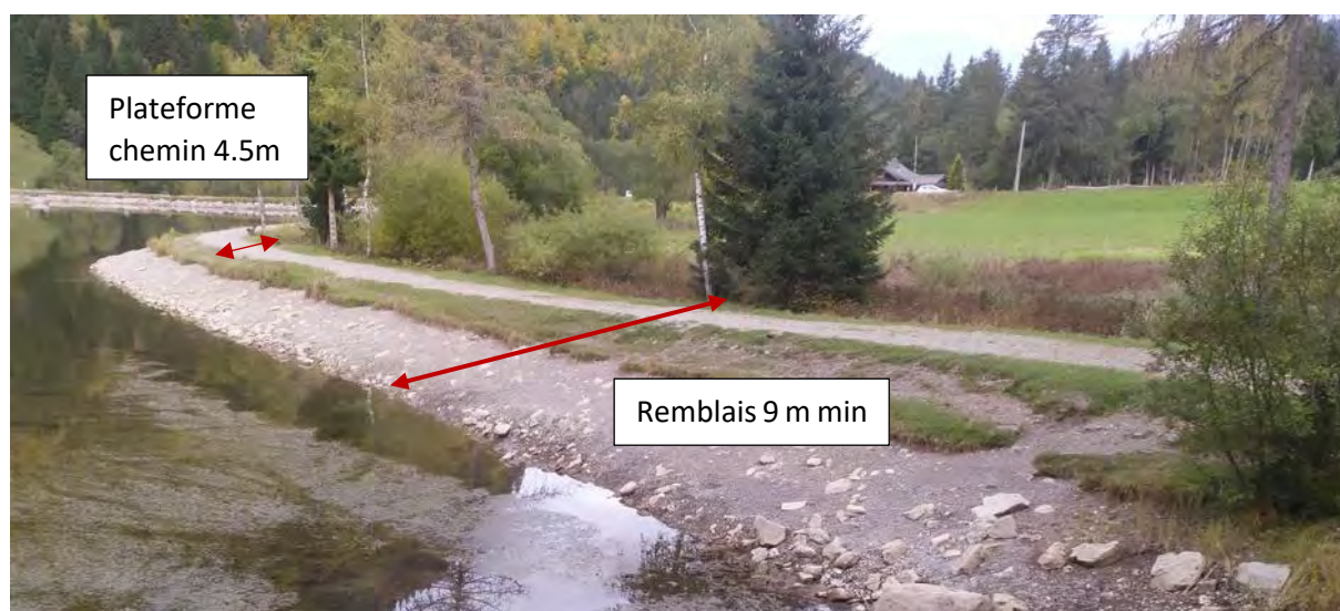
Figure 22 : emprise au sol du remblais et du chemin existant
