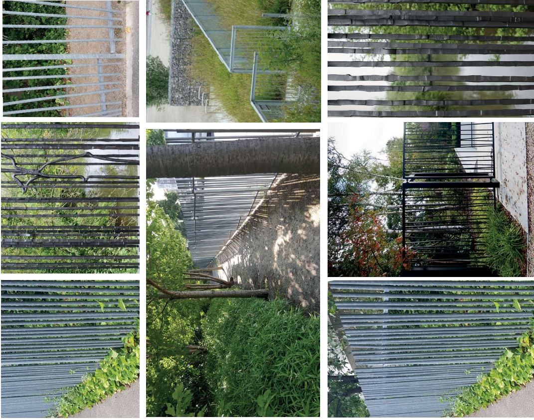
Clôture en serrurerie, éléments en acier, fers pleins, dimensions des montants et des éléments de remplissage harmonisés pour éviter l'effet «petit train»
