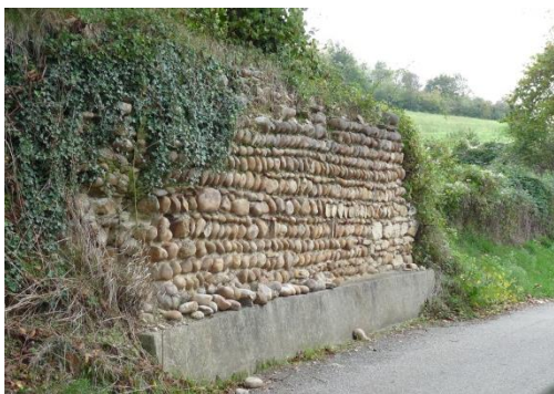
Mur traditionnel en galet au Canard
