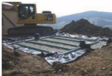
Travaux de réalisation d'un filtre à sable
