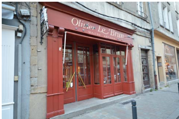
Exemple d'inscription de la banne dans la devanture : la banne est inscrite entre les piédroits en bois de la façade et au-dessous du coffre supérieur.
