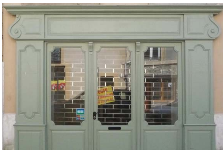
Lorsque la sécurité du local commercial nécessite un rideau roulant, celui-ci doit être placé derrière le vitrage. L'usage d'un rideau à mailles ou à lames micro-perforées permet de préserver l'attraction commerciale en évitant l'aspect « clos ».
