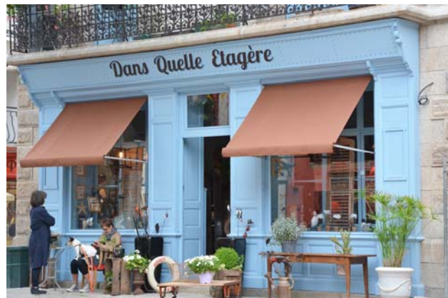
Exemple d'inscription de la banne dans la devanture : la banne est inscrite entre les piédroits en bois de la façade et au-dessous du coffre supérieur.
