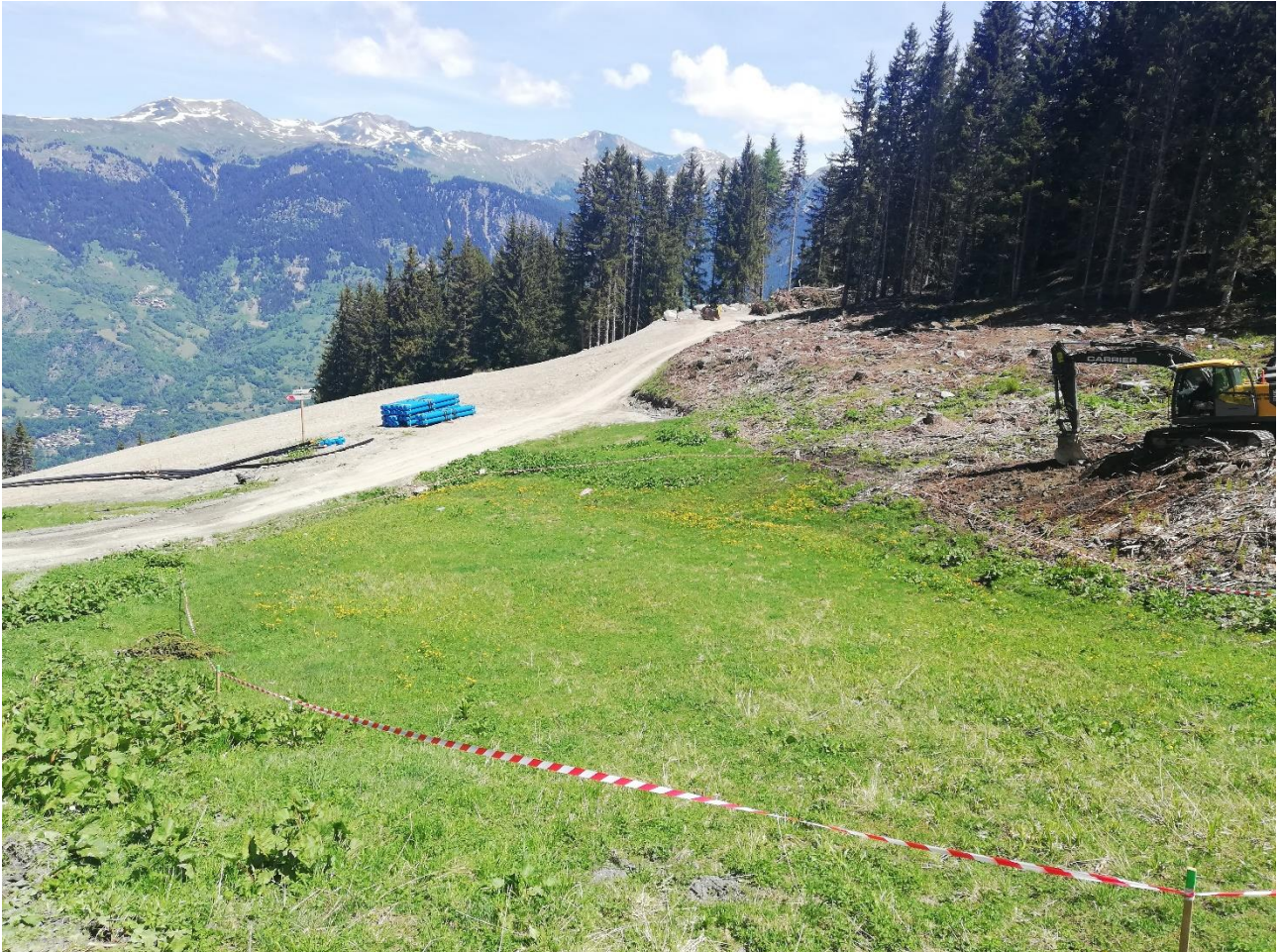
EXEMPLE DE MISE EN DEFENS INSTALLEE PAR LA S3V POUR DES TERRASSEMENTS (PISTE DES JOCKEYS) AUX ABORDS DE ZONES HUMIDES, JUILLET 2020
