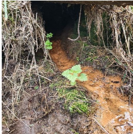
Figure 13 : Vue de l'érosion interne au niveau de la sortie du second bassin
