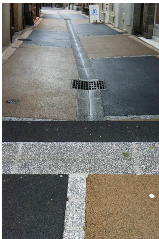
Ci-dessus : des matériaux incompatibles avec le centre ancien, par leur aspect bitumineux et l'absence de texture ; le décor en patchwork est hors d'échelle
