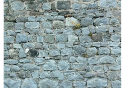
Murs à moellons posés par assises irrégulières
