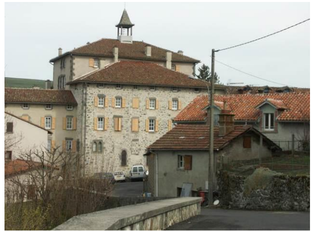
Façades moellonnées enduites « à fleur de moellons »
