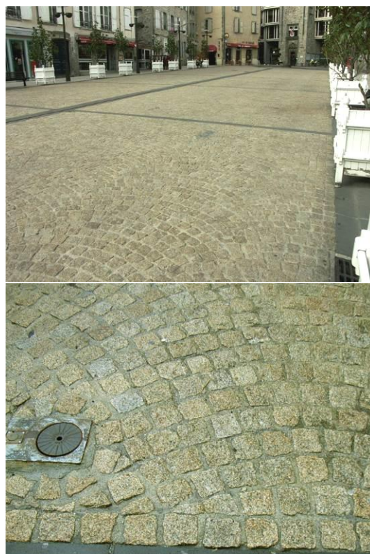
Ci-dessus, la qualité d'un pavage ou du dallage de pierre, en harmonie avec l'architecture de pierre et d'enduit des immeubles. Le sol est doté d'une texture qui s'adapte aux inflexions de la rue, assimile les défauts et les agressions de toutes sortes ; le matériau peut être indéfiniment remployé.
