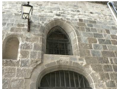
L'architecture médiévale se distingue par des appareils de pierre soigneusement assisés.
