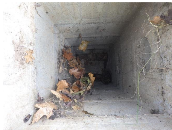
Couronne cassée et radier dégradé — Réseau d'eaux pluviales – R62
