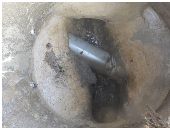
Raccordement défectueux – Réseau d'eaux pluviales – RD 115
