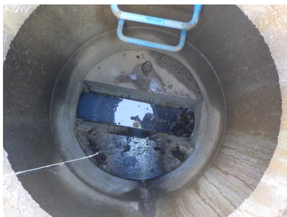
Stagnation d'effluent – Rue de la Thoranche – Réseau d'eaux pluviales – R77
