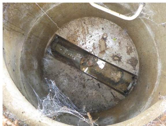
Dépôts –stagnation d'effluents– Réseau d'eaux pluviales – R186
