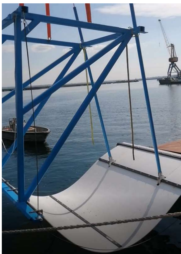
Figure 20 – Installation de du châssis, de la membrane et des mâts sur la barge sur le site de Brest
