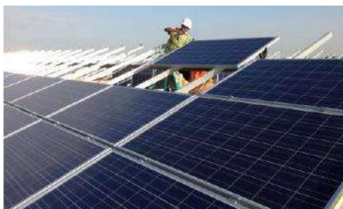
Figure 21 – Photographie pose des panneaux sur les supports
