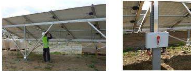
Figure 23 – Photographies du câblage des panneaux (gauche) et du boîtier de raccordement (à droite)
