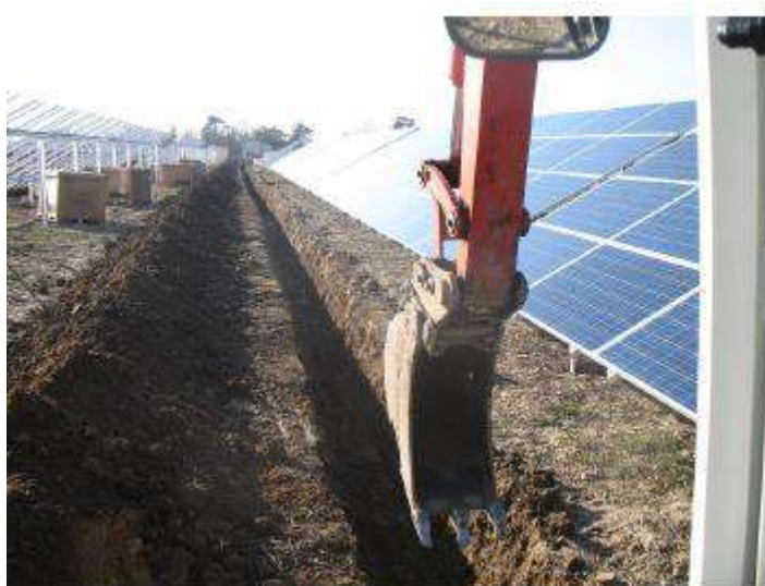
Figure 22 – Tranchée pour le passage des câbles
