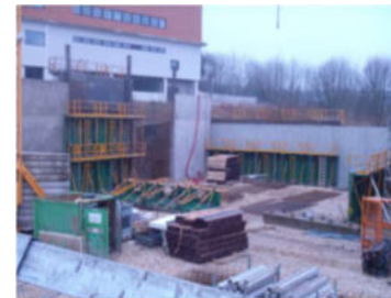
Mesure de Prévention : rangement rigoureux des banches, mannequins, accessoires ...
