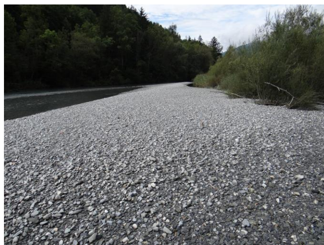
Aperçu du phénomène d'atterrissement constaté sur la queue de la retenue de Montrigon à cote basse
