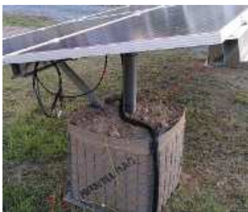
Exemple de solutions lestées commercialisées par les entreprises d'installation
