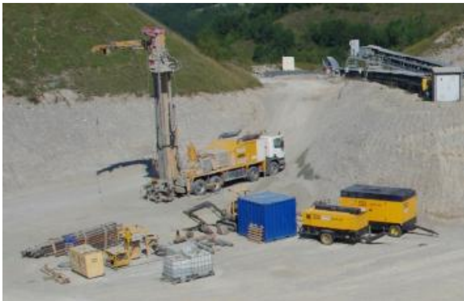
Photographie 1 : Foreuse / compresseur / stockage
