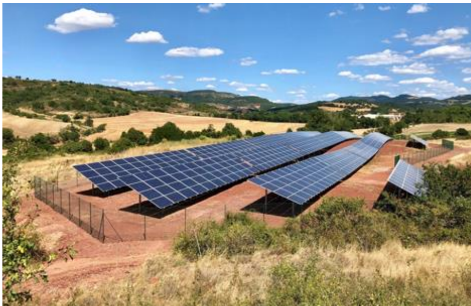
Exemple de structures fixes. Source : parc solaire de 249 kWc à Lagarde à Camares dans l'Aveyron (12) d'Enercoop Midi-Pyrénées sur une ancienne décharge
