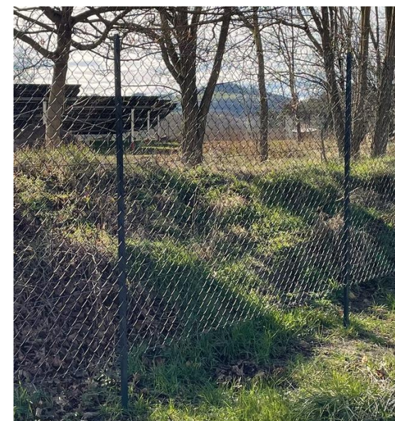
Grillage torsadé surélevé de 20 cm (parc PV Enercoop AURA - Egliseneuve-Près-Billom)
